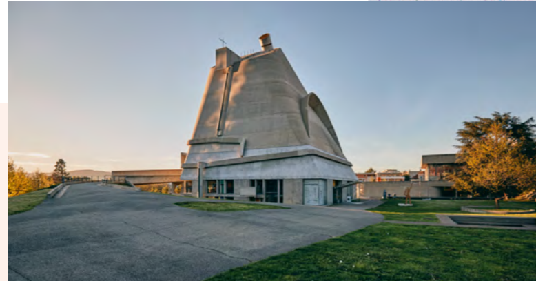
Église Saint-Pierre - Pierre Desrumeaux - Studio NORDE © F.L.C/ADAGP. Conception, Le Corbusier architecte, José Oubrière assistant (1960-65). Réalisation, José Oubrière architecte (1970-2006).
