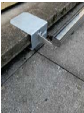
appareil LED linéaire, monté sur le larmier par étrier à vis de pression
