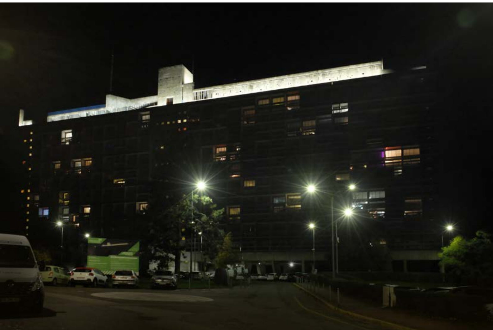
vue sur la façade Est
