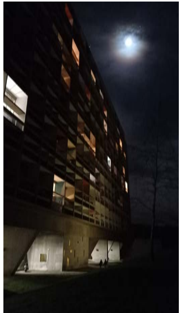
vue sur la façade Ouest
