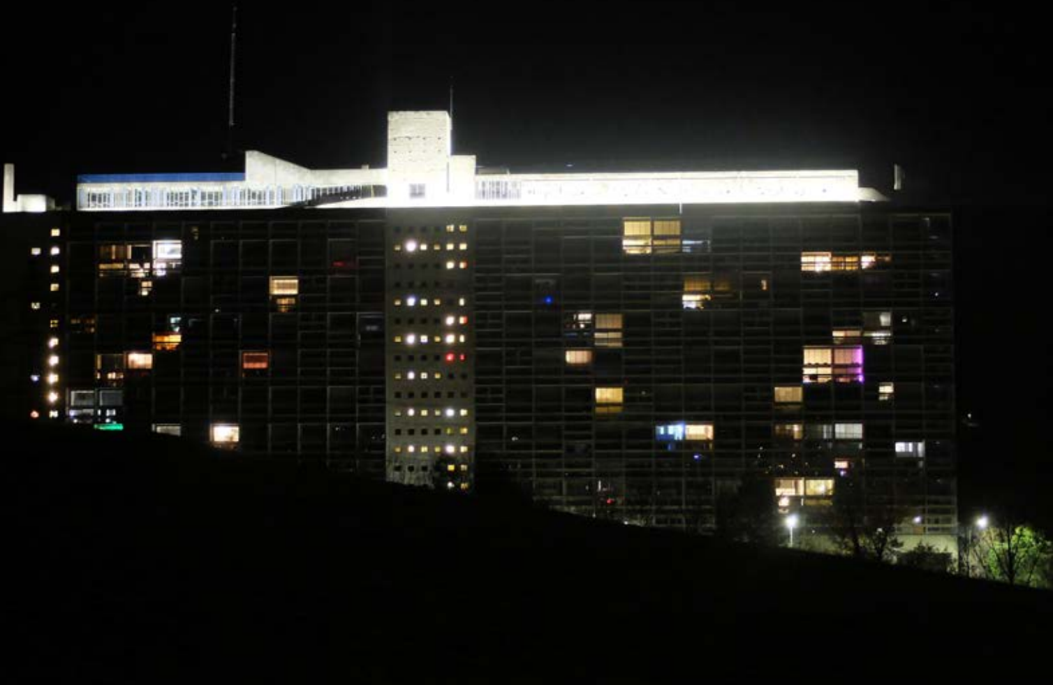
vue sur la façade Est
