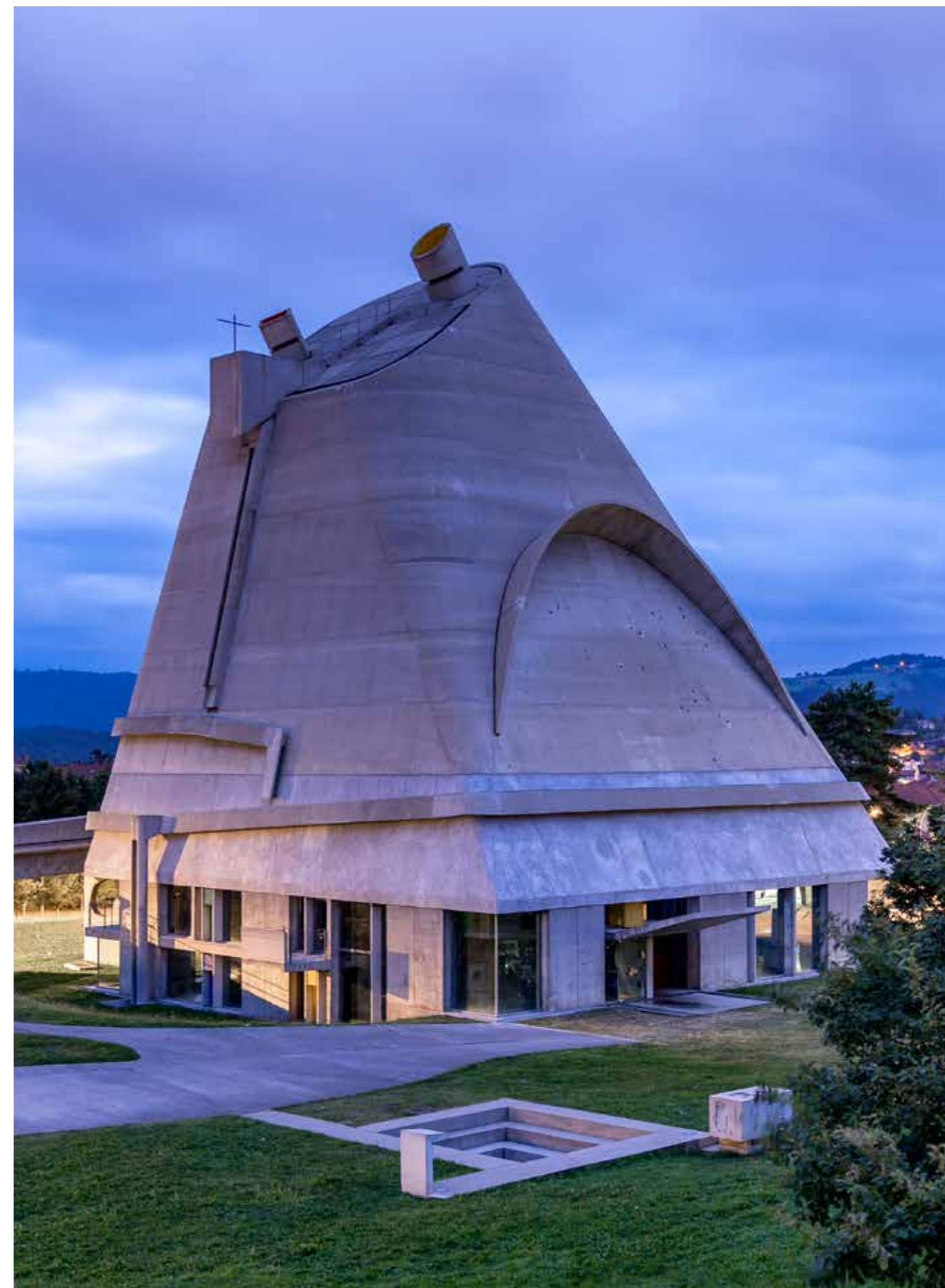
Église Saint-Pierre - Yohann Merlevede © FLC/ADAGP. Conception, Le Corbusier architecte, José Oubrière assistant (1960-65) Réalisation, José Oubrière architecte (1970-2006)
